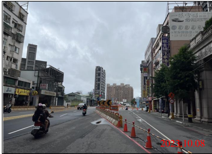
巡查日期地點：112.10.08/ Y22車站 照片說明：路面狀況
