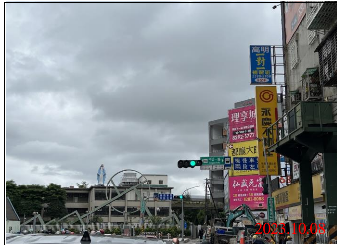
巡查日期地點：112.10.08/ Y21車站 照片說明：牌面設置狀況
