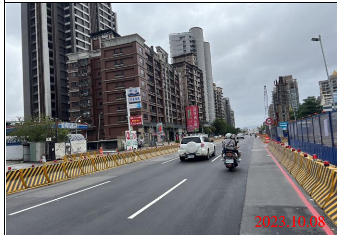
巡查日期地點：112.10.08/ Y23車站 照片說明：路面狀況
